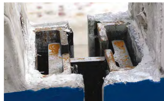
5. L'innovativo sistema di collegamento dei moduli in calcestruzzo
