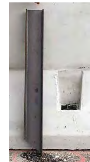
6A e 6B. Il sistema di ancoraggio della barriera NDBA su rilevato
