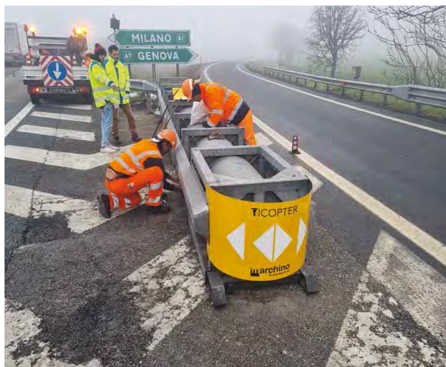
3. Il riposizionamento della barriera ZMP100 sulla A26 3. The reposition of a ZMP100 barrier on the A26
