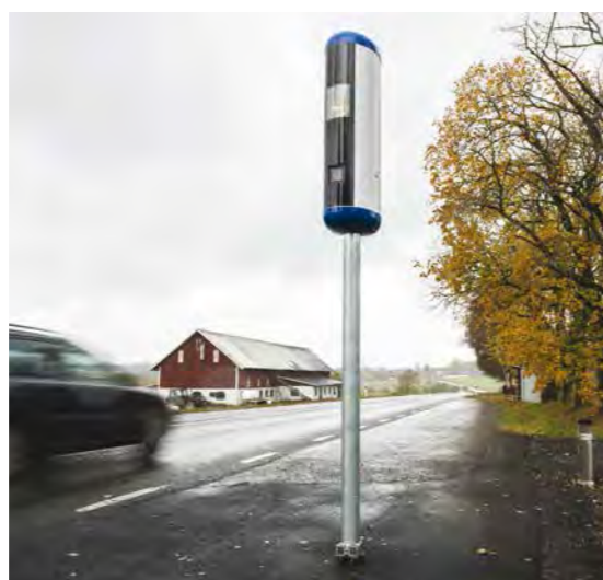
6. Telecamere di sicurezza per il traffico (photo credit: Kerstin Ericsson, Trafikverket - Swedish Transport Administration)
