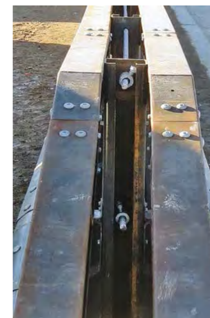
2. Un particolare del tondino centrale e superiore della H4 ST DSM
