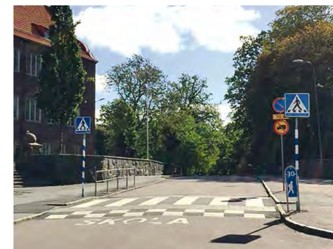
5. Un dosso - dissuasore di velocità - fuori da una scuola (photo credit: Thomas Berggren, City of Gothenburg)
