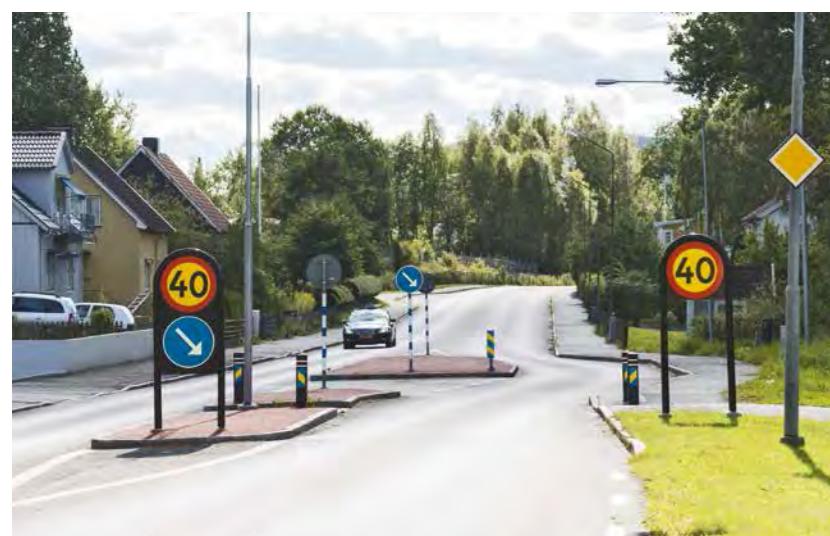
2. Misure per la riduzione della velocità (photo credit: Kerstin Ericsson, Trafikverket - Swedish Transport Administration)
